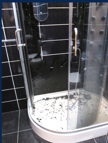
Разрушение стеклянной стенки душевой кабины
